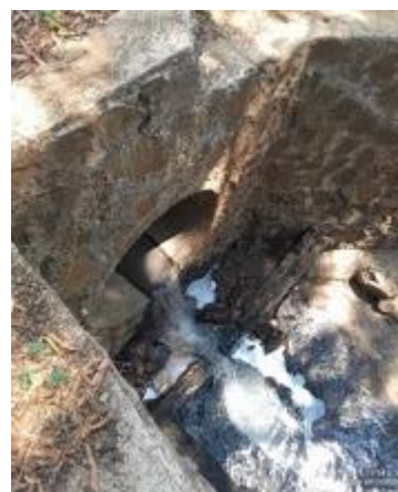
Ilustración 4 Descarga de colector principal de aguas pluviales
