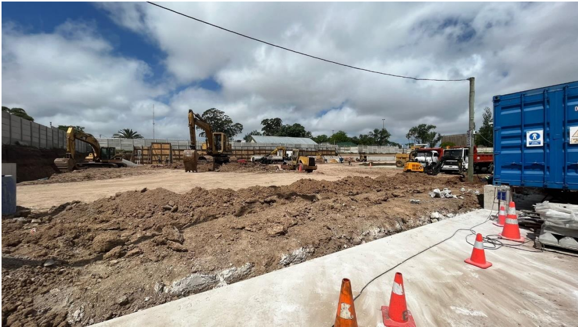
Obra civil en planta Añón
