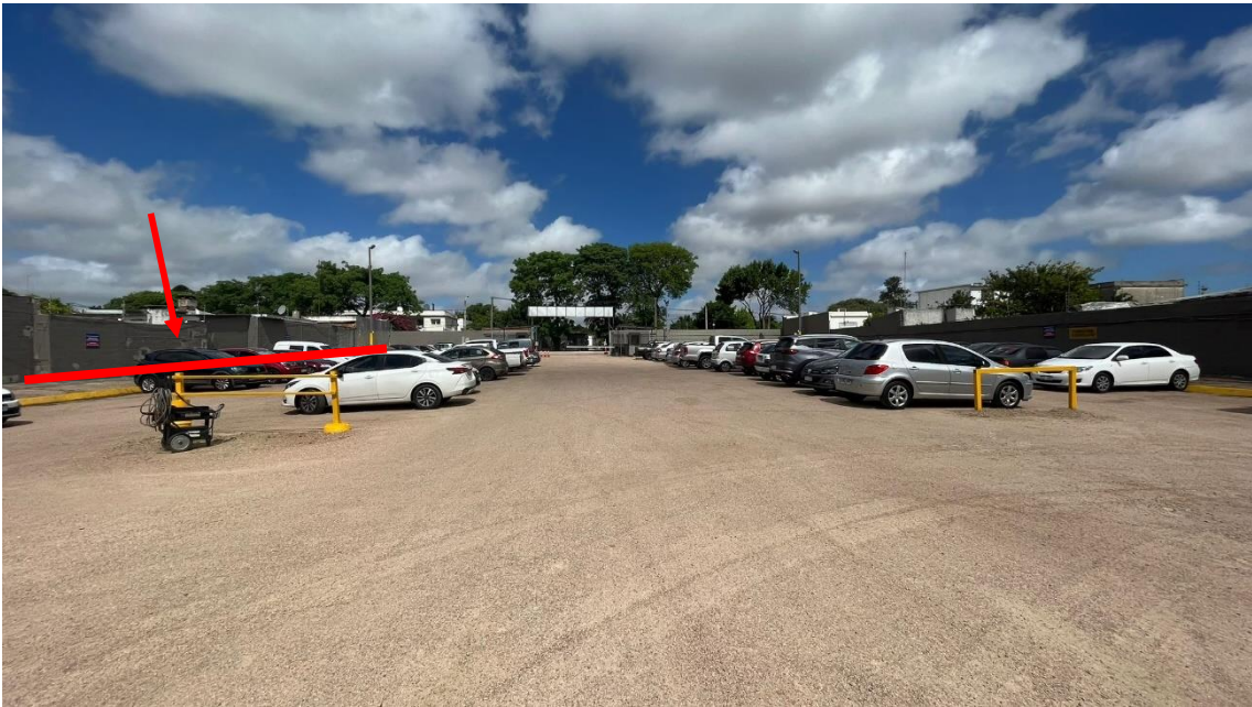
Planta Islas Canarias – zona de cargadores a instalar
