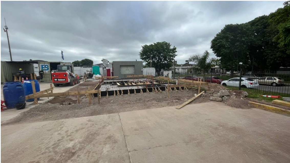
Obra civil en planta Juan A. Salgado
